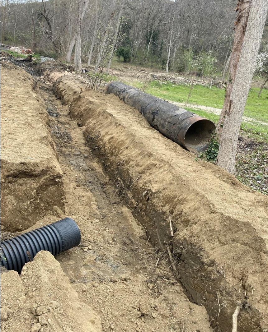
Merkez Küplü Köyü Sulama Kanalı Onarımı
