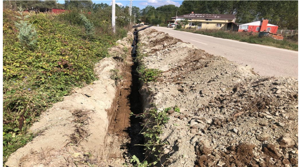
Pazaryeri Kınık Köyü Kanalizasyon
