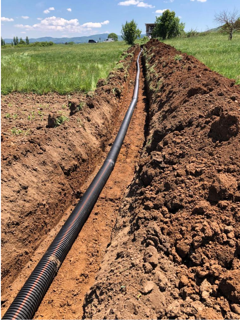
Pazaryeri Küçükmalı Köyü Kanalizasyon
