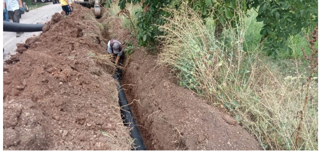
Gölpazarı Gökçeler Köyü Kanalizasyon
